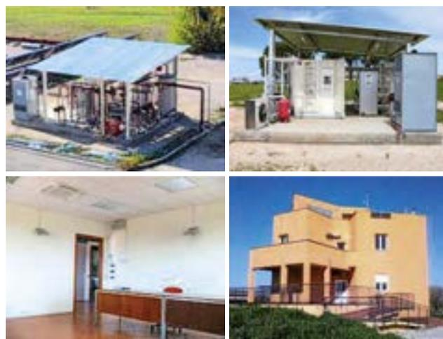
**Figura 1 – Viste dell'impianto e dell'edificio F-92.** L'impianto può essere suddiviso in centrale di produzione, campo solare, termodotto di collegamento tra la centrale di produzione ed edificio, sottocentrale di edificio che smista ai vari circuiti il fluido termovettore, terminali d'impianto, rappresentati da pannelli radianti a pavimento e da fan coil a cassetta installati a soffitto.
